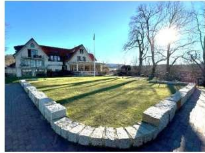
Das begrünte Dach des Gipfelpostens.
